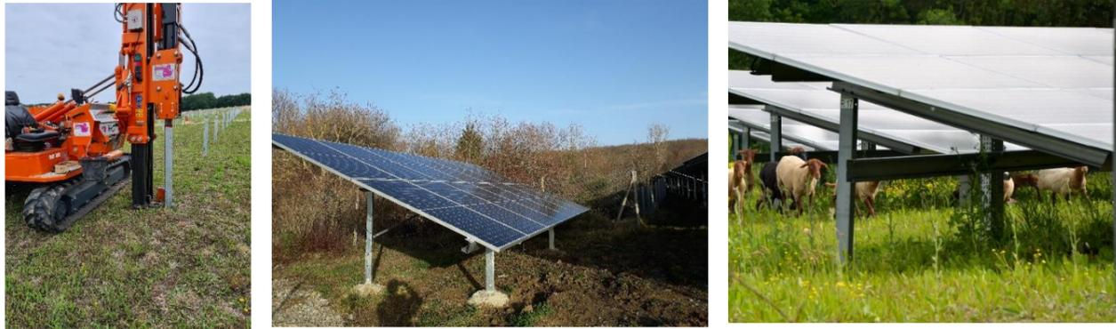
Figure 18 : Exemple de pieux forés bétonnés et battus
