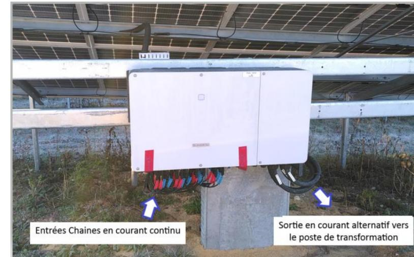
Figure 9 - Onduleur décentralisé
