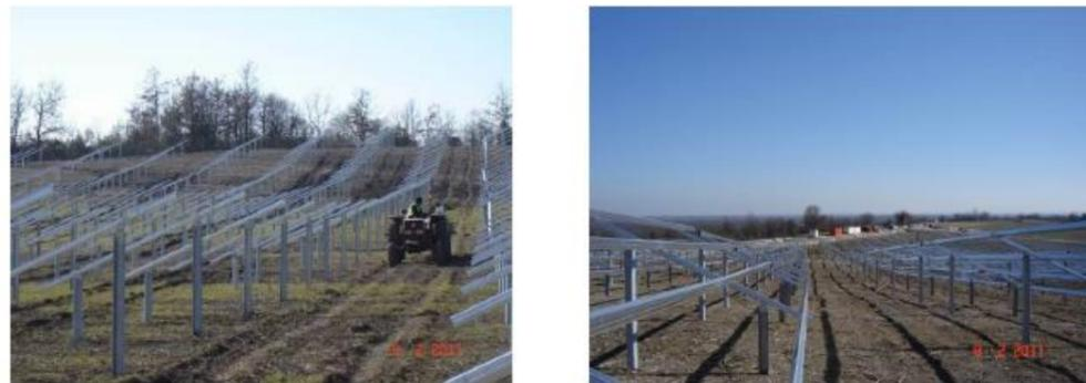
Figure 19 : Montage des structures porteuses
