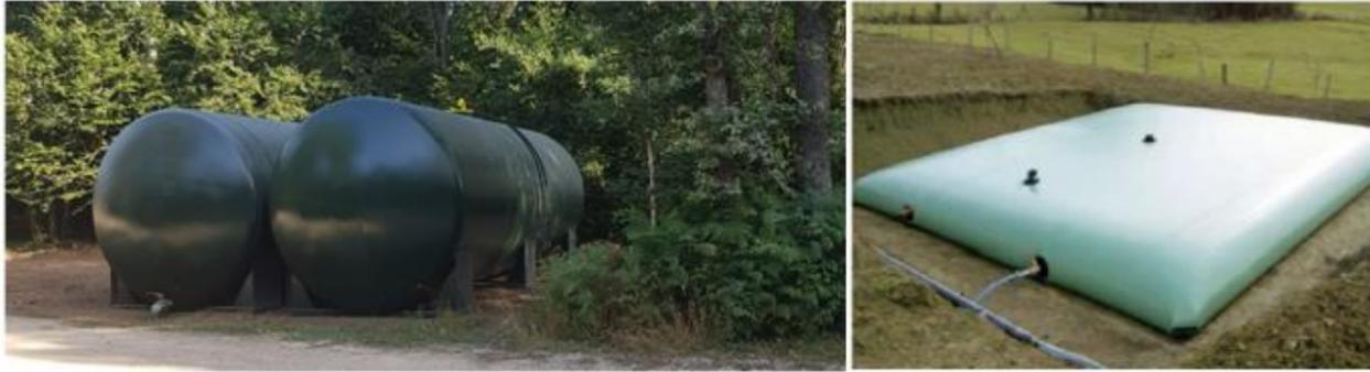
Figure 13 : Exemple de réserves d'eau artificielles métalliques (à gauche) et souple (à droite)
