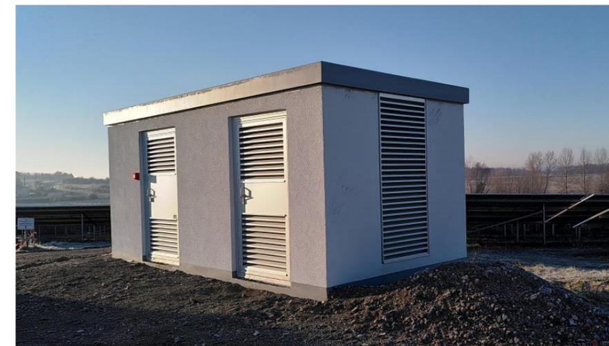
Figure 10 - Poste de transformation remblayé
